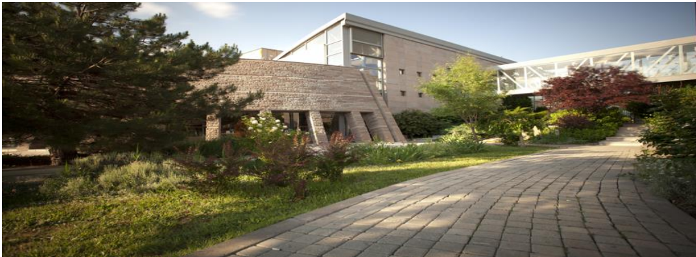
Teknokent alanı içinde bulunan binalar ve alan bilgileri Tablo 3'te gösterilmiştir.
